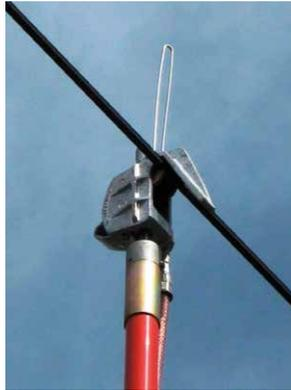
Abbildung 14f: Einhängen der Fahrdrahterdungsklemme
