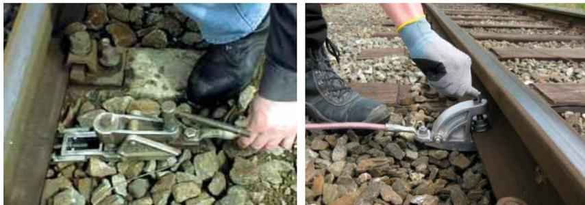
Abbildungen 14a und 14b: Befestigen der Schienenfußerdungsklemme
