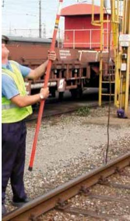
Abbildung 14c: Aufrichten der Erdungsstange
