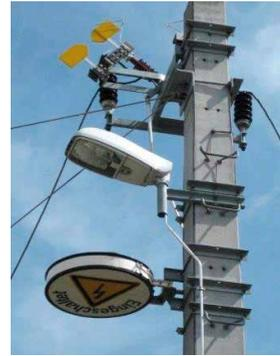
Abbildungen 13f, 13g und 13h: Schaltzeiger „Ausgeschaltet“/Stellschaltzeiger „Erdung ein“
