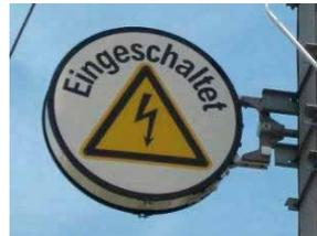
Abbildung 11a und 11b: Schaltzeiger „Oberleitung des Ladegleises ist eingeschaltet“
